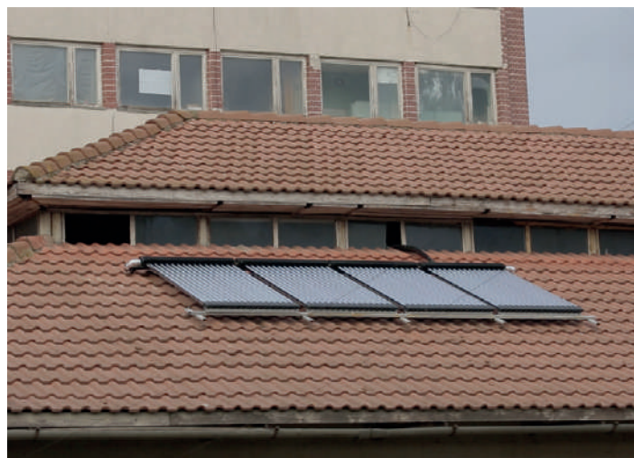
Солнечные тепловые коллекторы на крыше исследовательской лаборатории в Бельцах.
