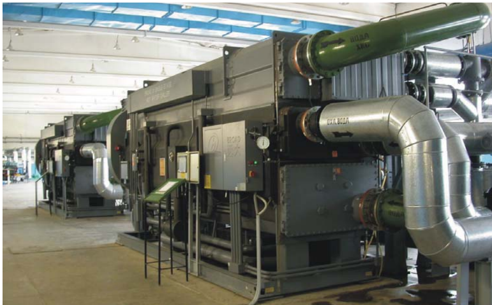
Абсорбционная холодильная машина BS200X
