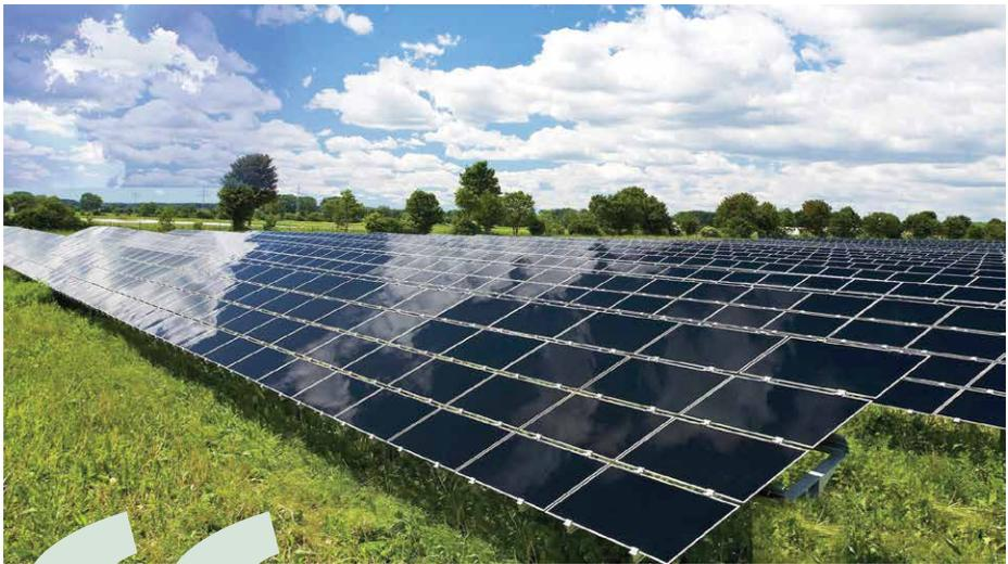
По проекту в парке будет установлено 4 тысячи 752 солнечных панели. Каждая из них имеет номинальную мощность 335 Вт. В результате установленная мощность всего парка солнечных батарей составит 1,6 МВт.
