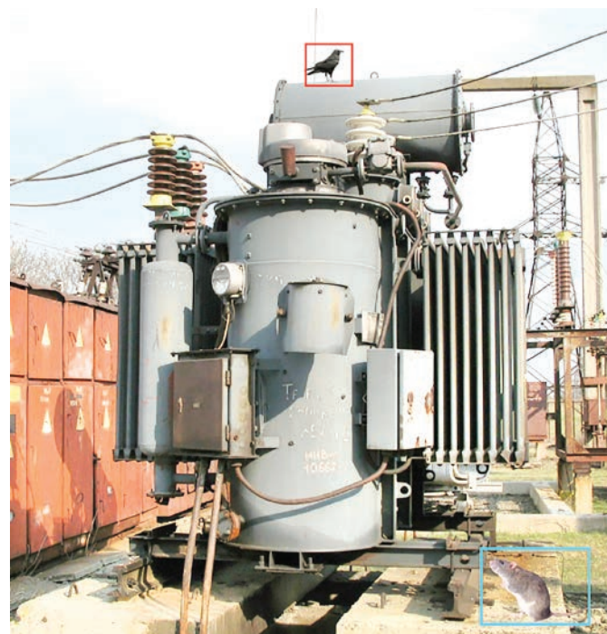
Рис. 10. Пример применения нейронных сетей для обнаружения посторонних птиц и грызунов с помощью фотофиксации объектов
