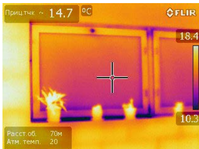
Рисунок 45 – Изображение участка стены внутри здания
