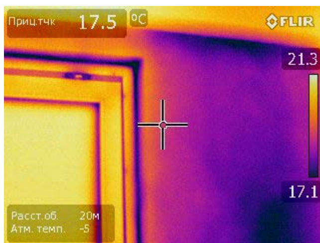
Рисунок 9 – Изображение участка стены внутри здания
