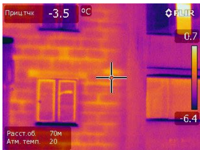
Рисунок 41 – Изображение участка фасада жилого здания в ИК-диапазоне
