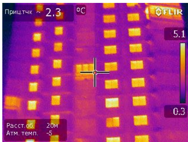
Рисунок 35 – Изображение участка фасада жилого здания в ИК-диапазоне
