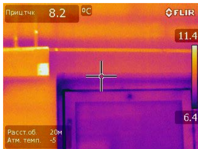
Рисунок 27 – Изображение участка стены внутри здания
