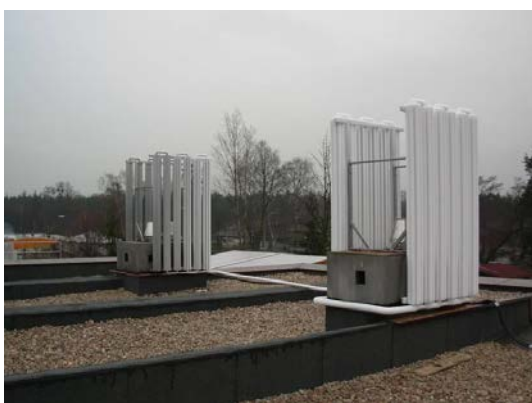
Фото 1.3 - Размещение испарителей на крыше зданий
