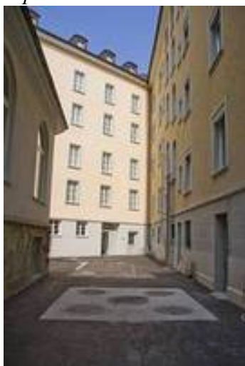
Фото 2: Вид крышки резервуара с теплообменником-утилизатором
