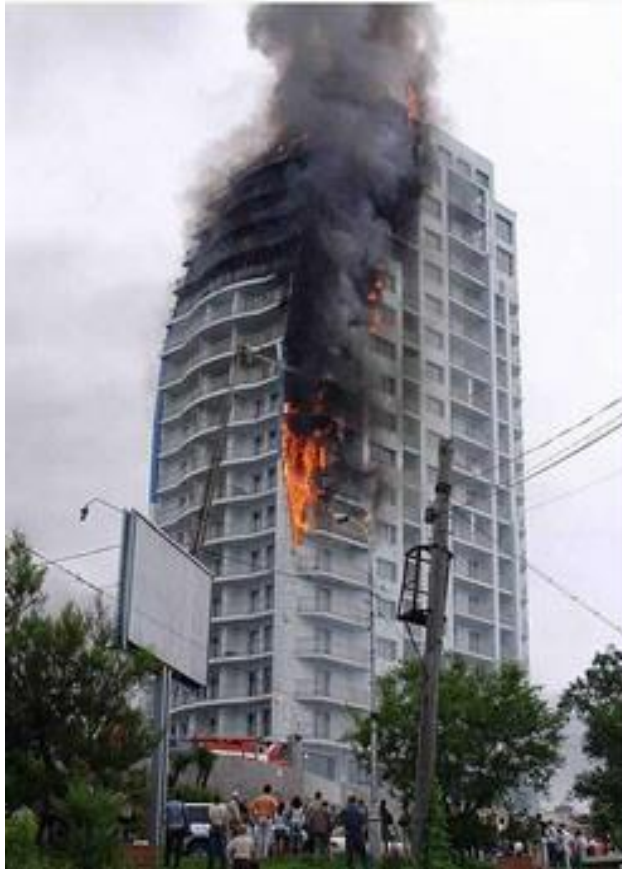
Пожар во Владивостоке - горит пенополистирол наружного утепления.
