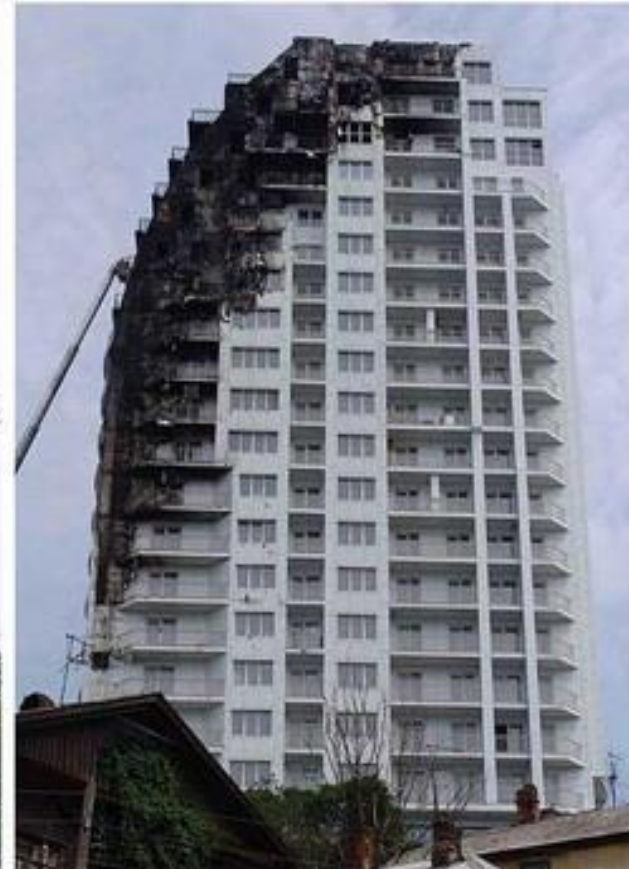
Пожар во Владивостоке - горит пенополистирол наружного утепления.
