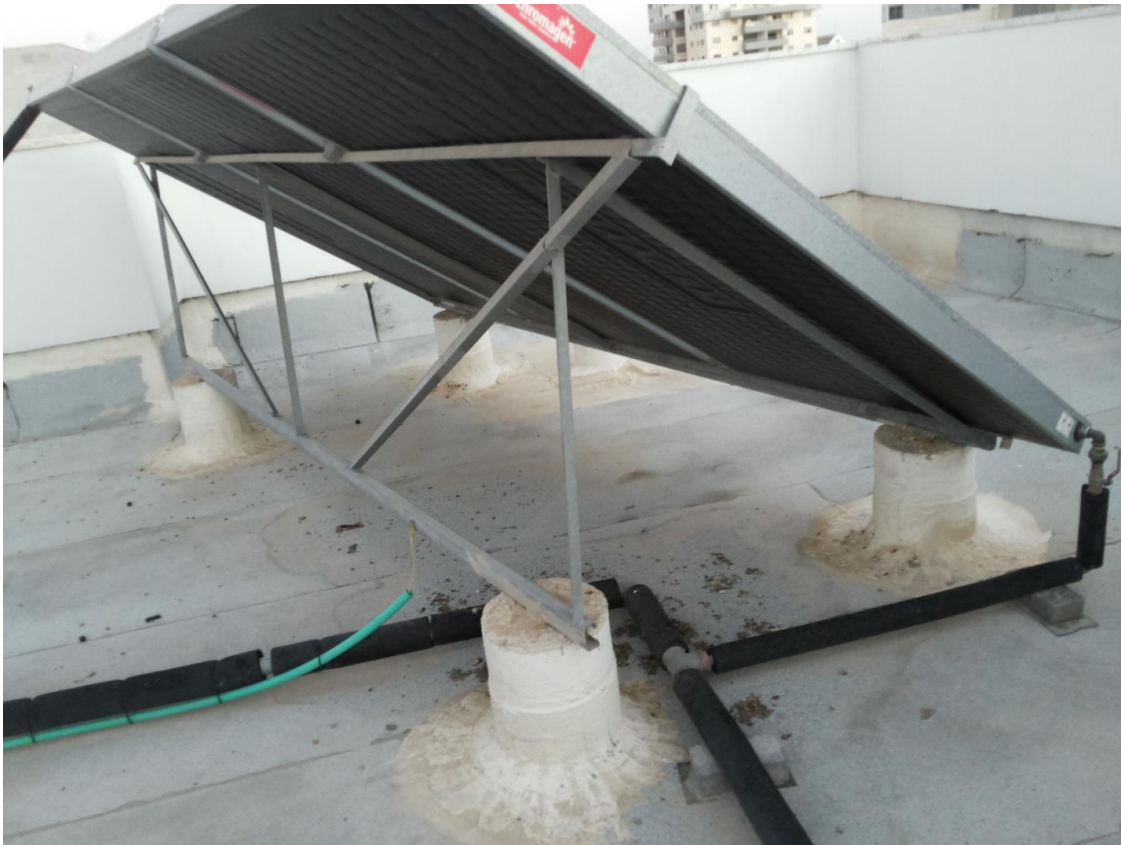
Рисунок 5 – Пример монтажа элементов солнечных коллекторов на крыше здания
