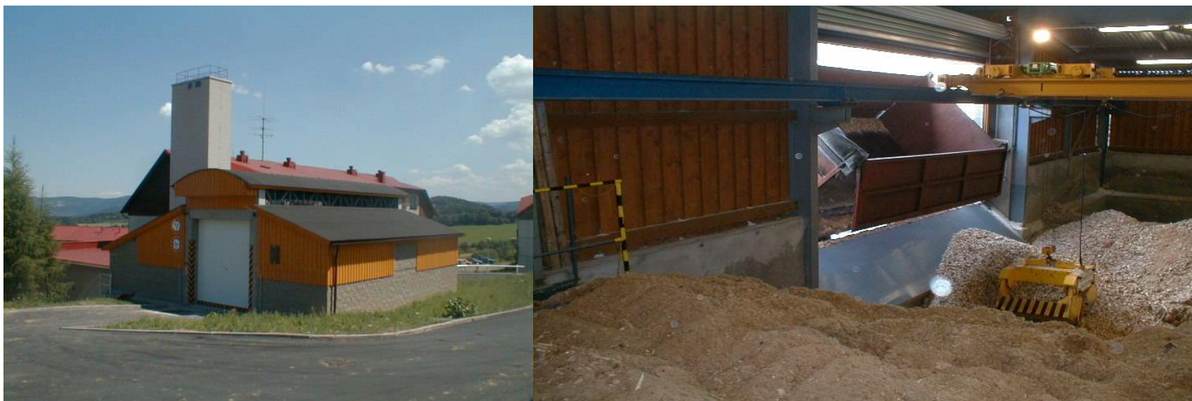
Отопительная система в Гартманице, источник: инженер Йозеф Фартак, EGF, spol. s r.o.
