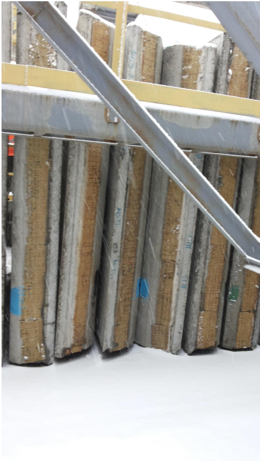
Рисунок 8. Энергоэффективное панельное здание в г. Могилеве. Стеновая панель
