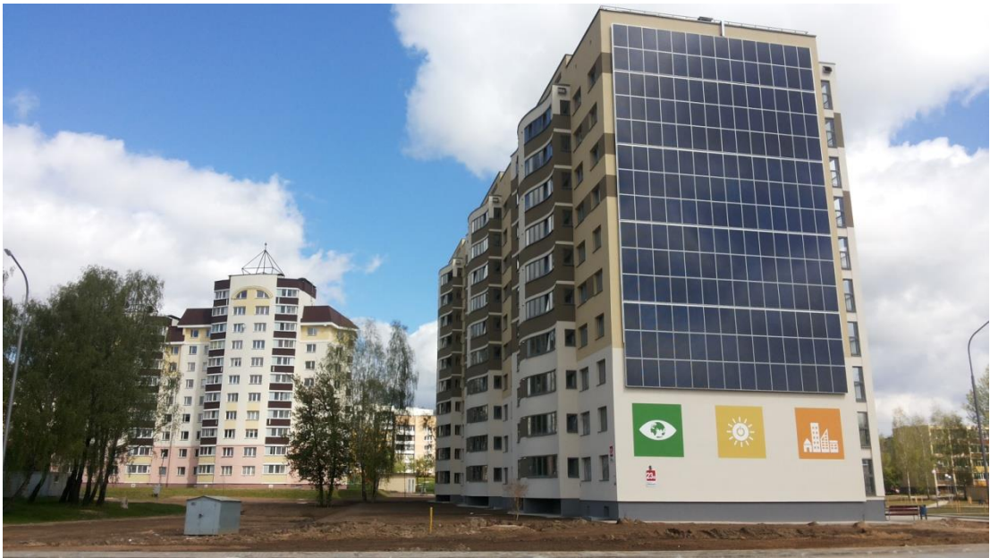
Рисунок 25 – Законченное строительством здание в г. Гродно
