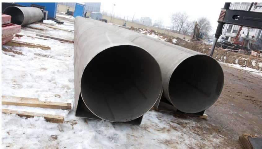
Рисунок 21 - Фотография трубы-вставки с теплообменной полостью в нижней части.
