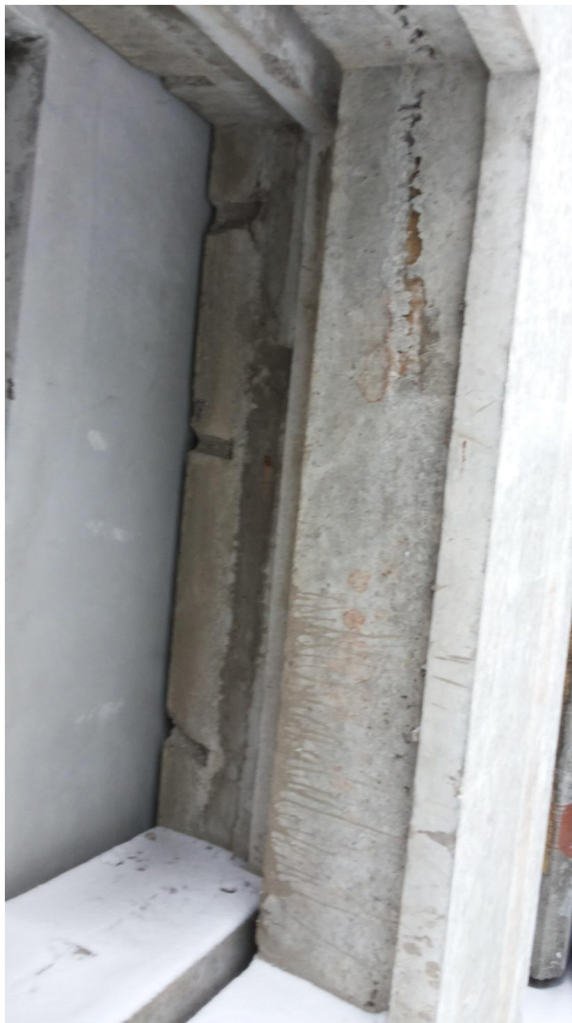
Рисунок7 Энергоэффективное панельное здание в г. Могилеве. Оконный проем
