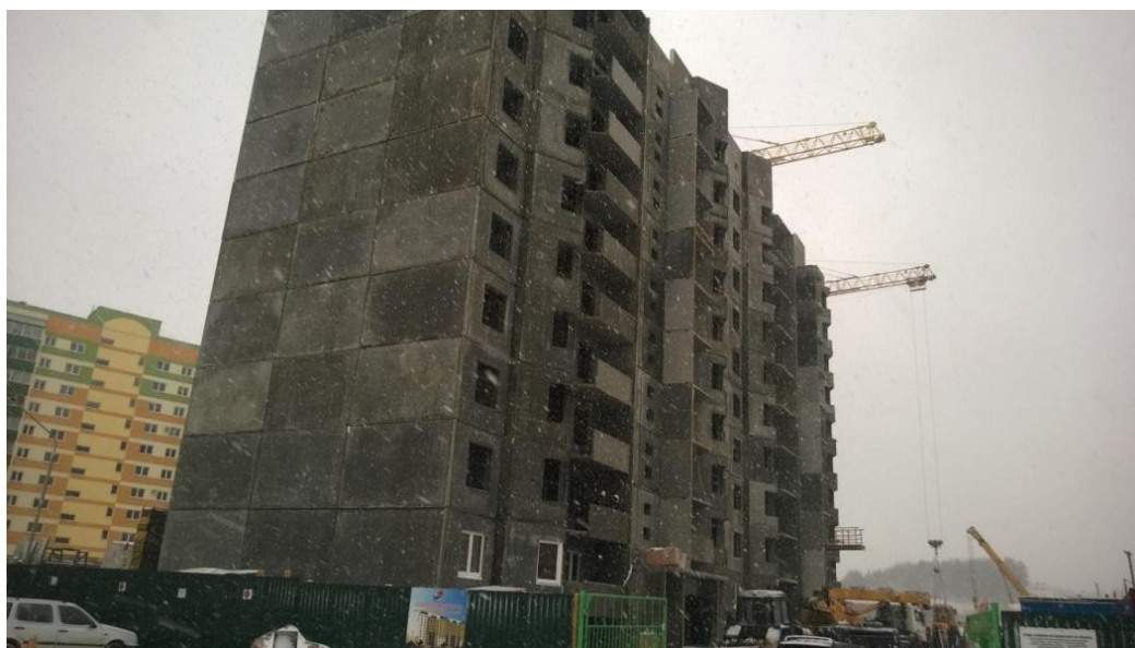
Рис. 6 Энергоэффективное панельное здание в г. Могилеве на стадии строительства
