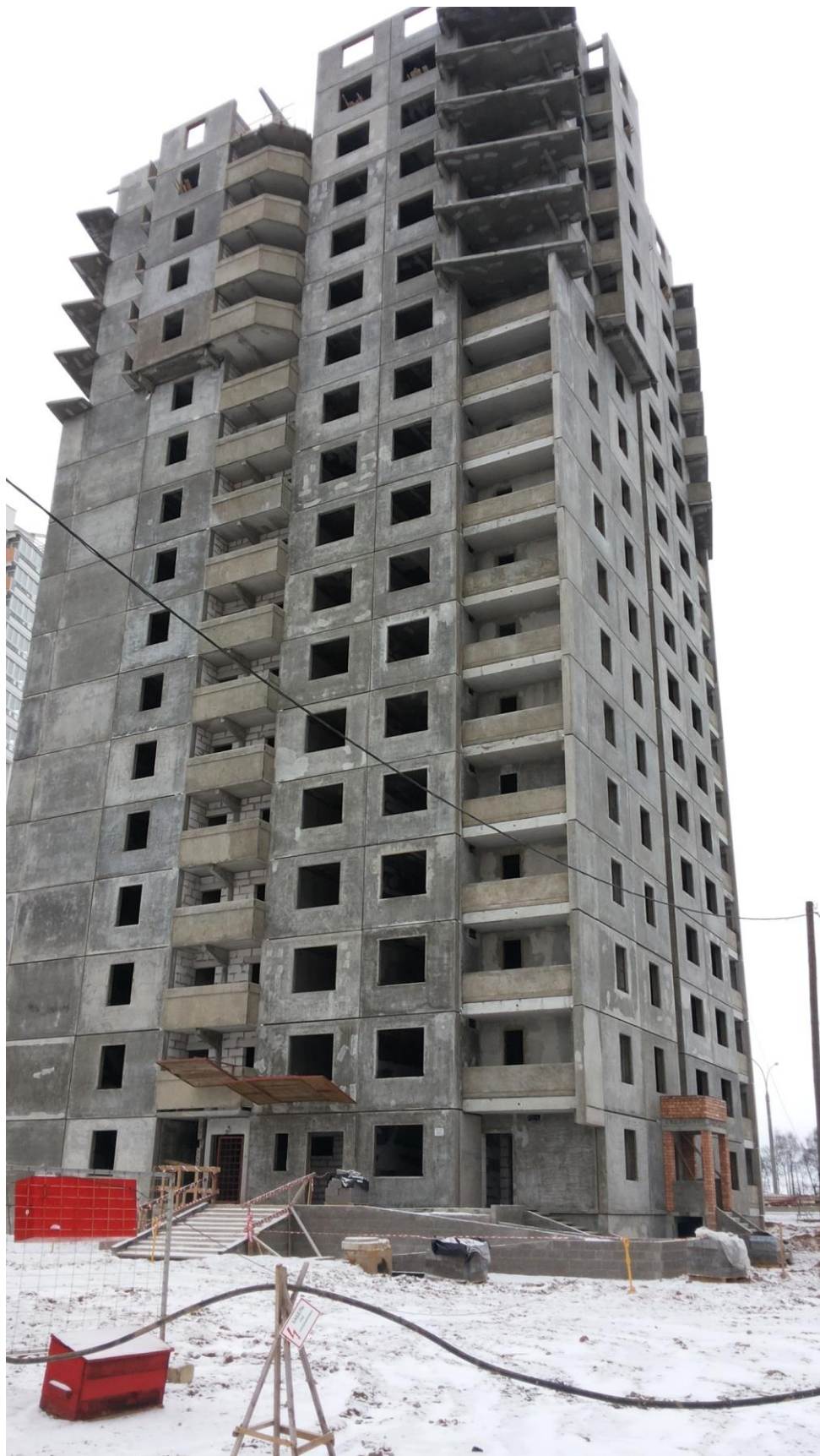
Рисунок 1 Энергоэффективное здание в г. Минске на стадии строительства
