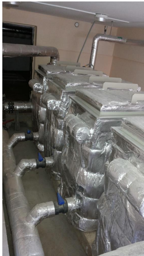
Рисунок 4 система утилизации тепловой энергии сточных вод
