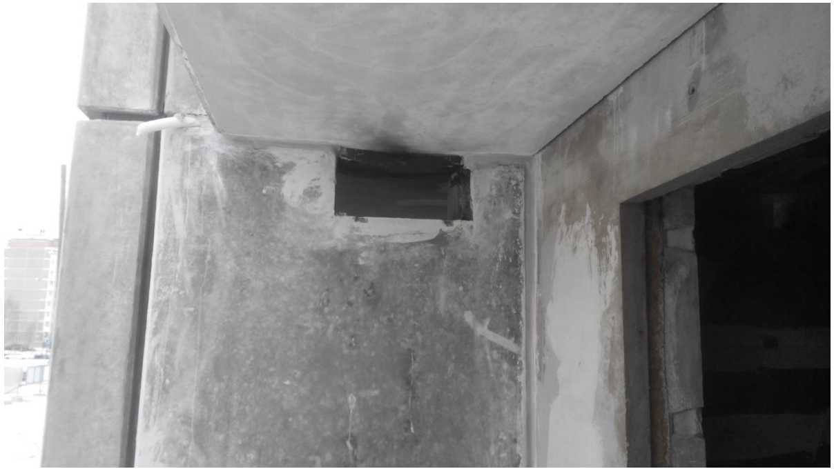
Рисунок 3 Отверстие в стеновой панели для прокладки воздуховодов
