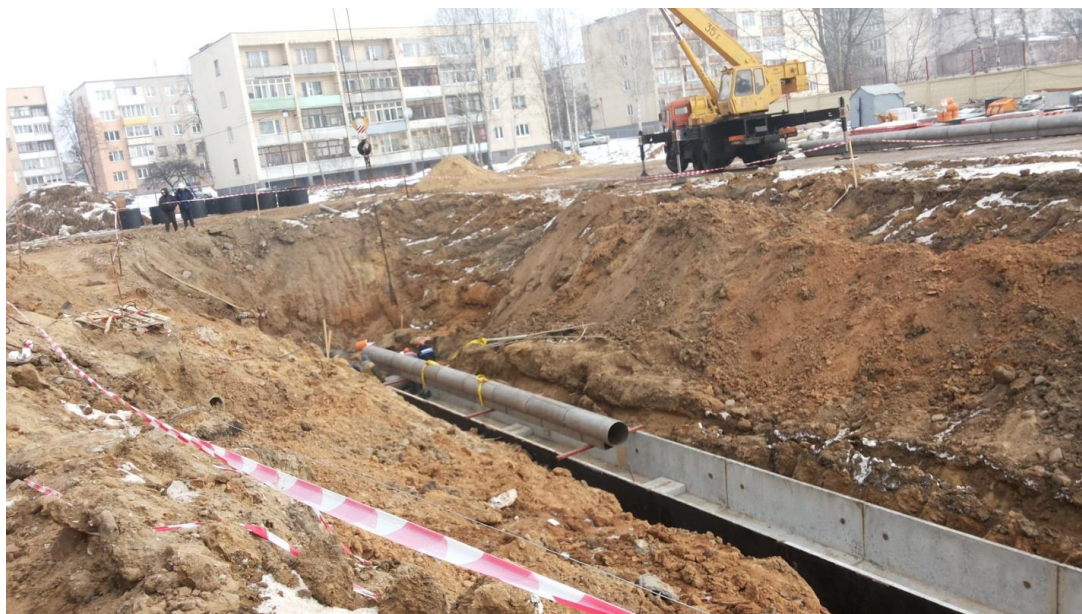
Рисунок 23- Работы по монтажу вставки
