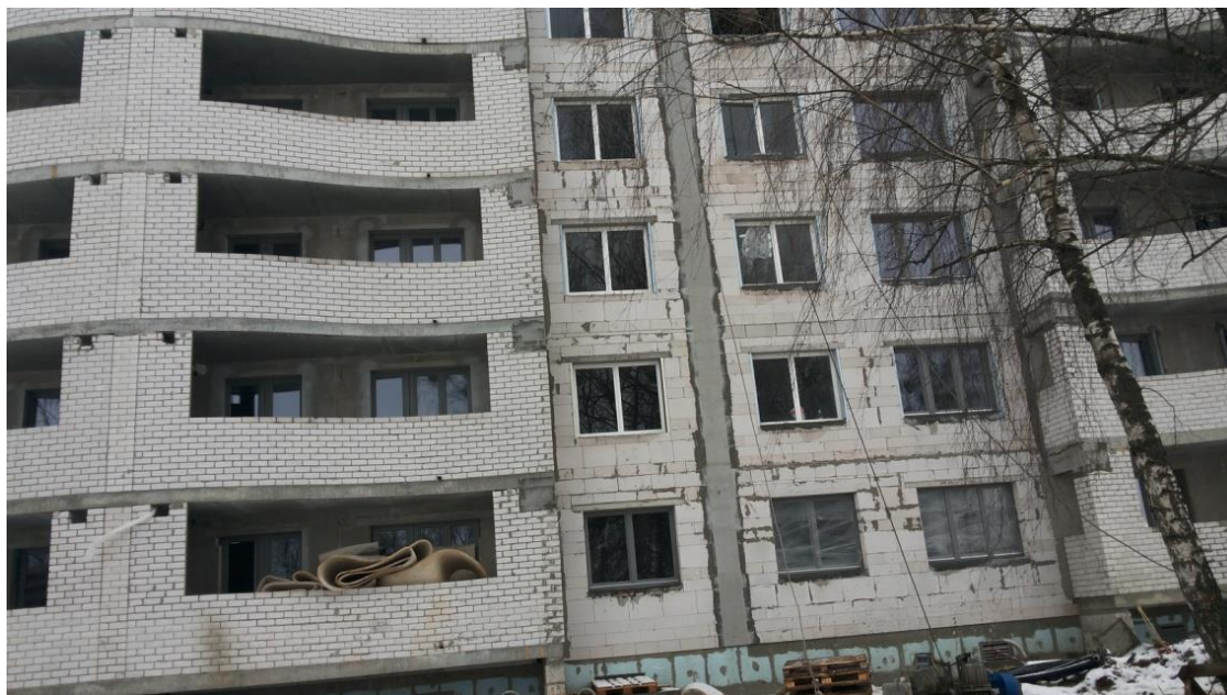
Рисунок 16- Фотография здания на стадии строительства
