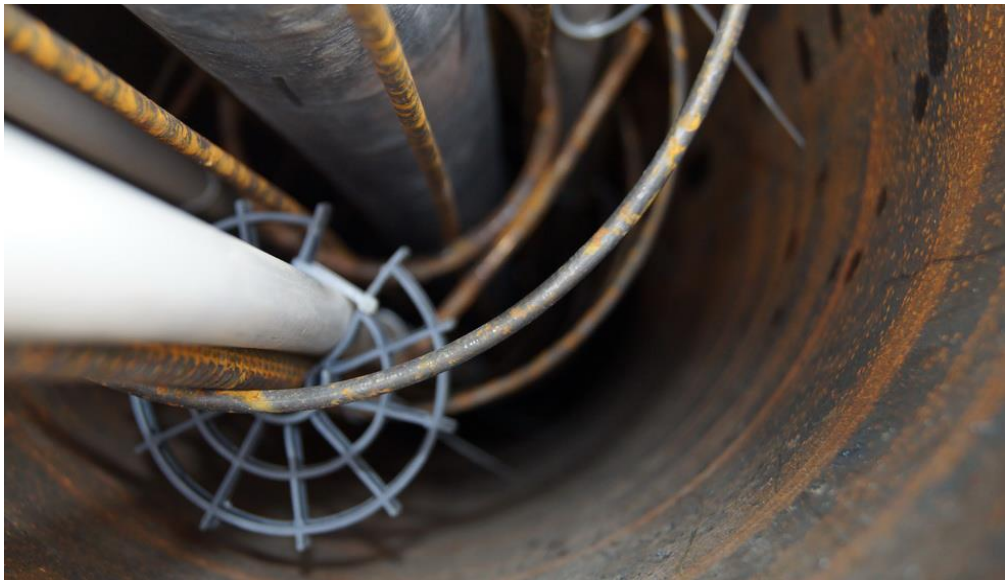
Рисунок 19- Фотография с места монтажа свай для теплового насоса, снимающего низкопотенциальную энергию с фундаментных свай здания
