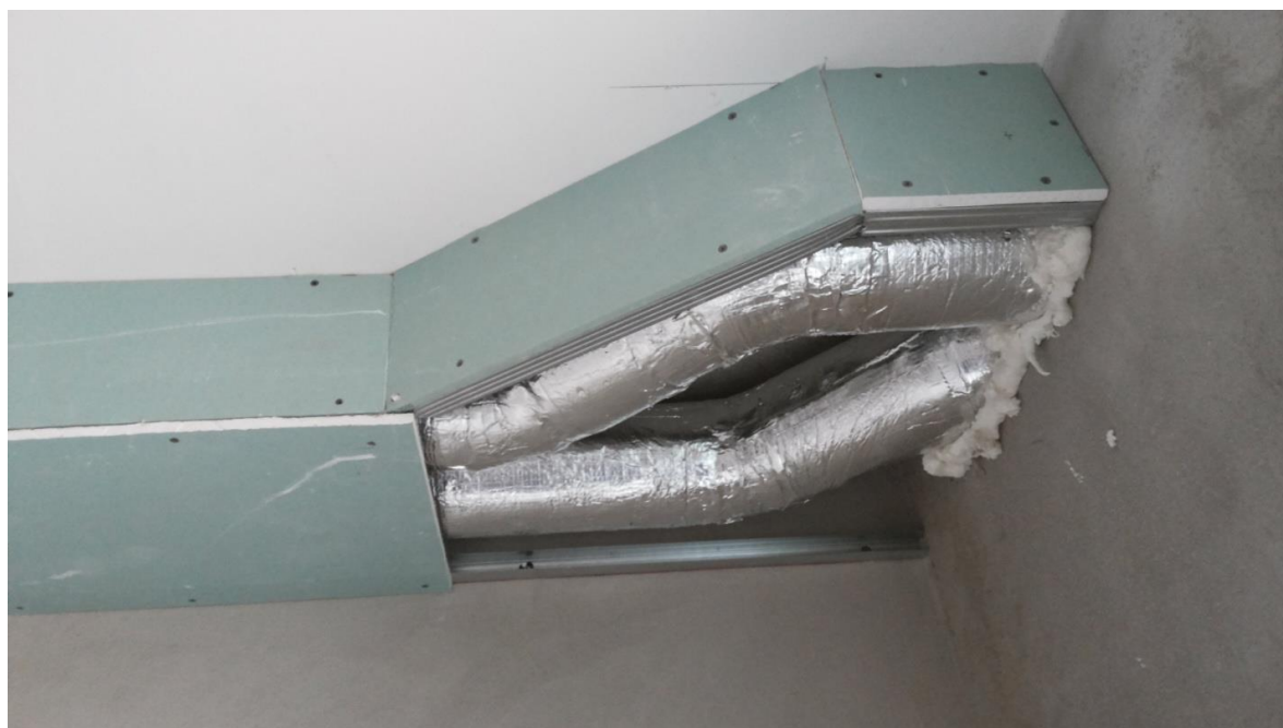
Рисунок 17- Фотография монтажа воздуховодов в квартирах.
