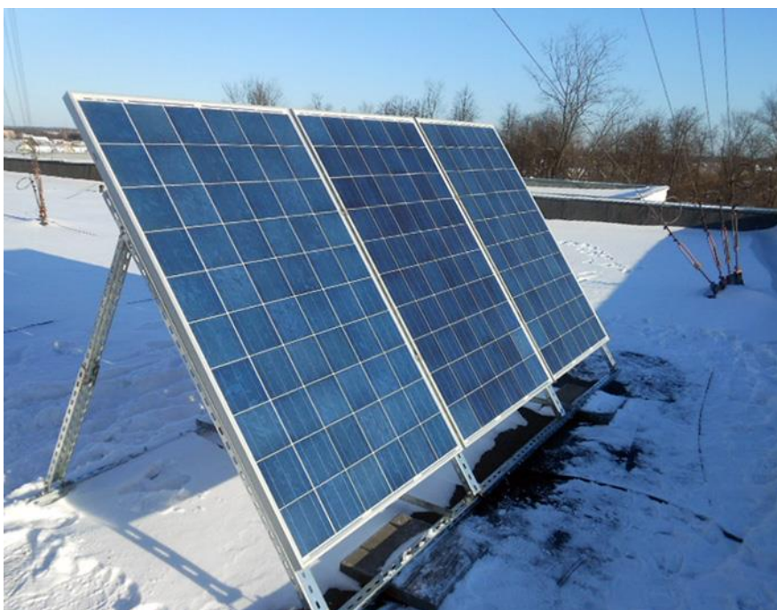
Рисунок 2.6 — Система автономного электроснабжения мощностью 750 Вт: центральная библиотека в Марьиной Горке, Пуховичский р-н;
