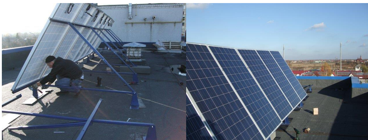
Рисунок 2.15 — Установка по производству электрической энергии из возобновляемых источников энергии (солнце) мощностью 10 кВт по адресу: г. Брест, ул. Луцкая;
