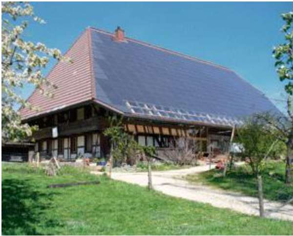
Рисунок 2.23 — Фотоэлектрическая установка, все элементы которой являются частью кровли здания (Ферма в Морисвиле)
