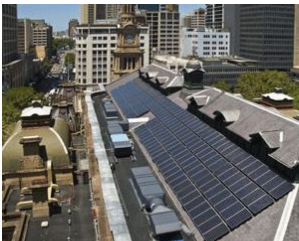
Рисунок 2.22 — Размещение модуля поверх конструкции. Каждый модуль можно испытывать отдельно, т. к. их работа не связана друг с другом
