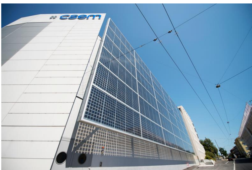
Рисунок 2.27 — BIPV-фасад в Швейцарии
