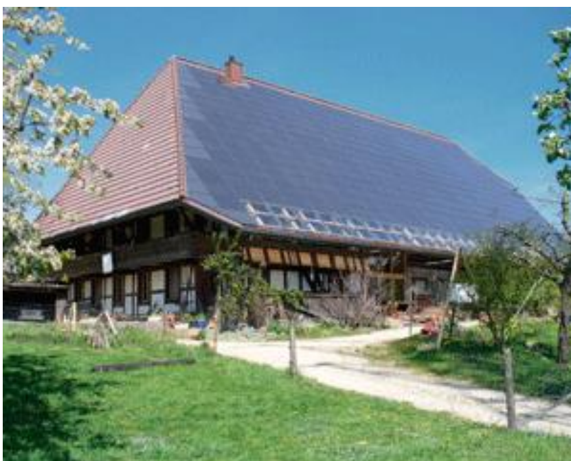
Рисунок 4.5 – Фотоэлектрическая установка, все элементы которой являются частью кровли здания (Ферма в Морисвиле)
