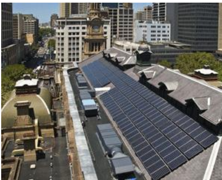
Рисунок 4.4 – Размещение модуля поверх конструкции. Каждый модуль можно испытывать отдельно, т. к. их работа не связана друг с другом
