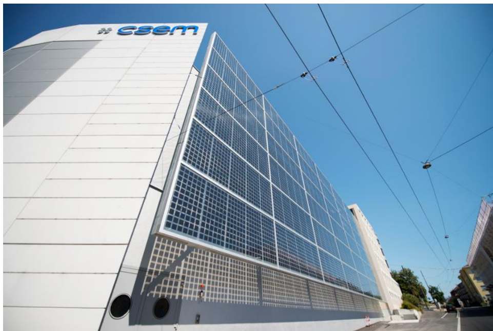
Рисунок 4.7 – BIPV-фасад в Швейцарии
