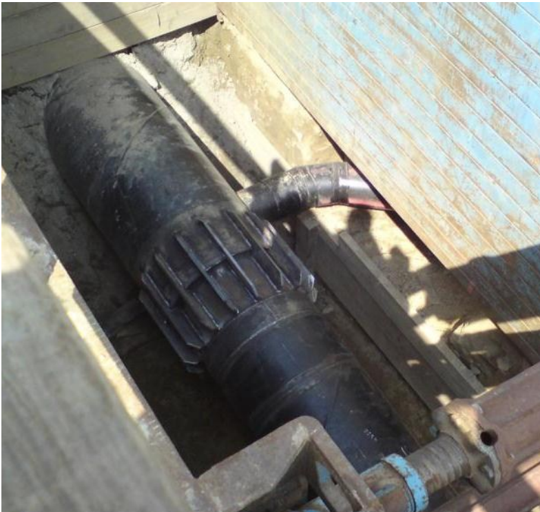
Endstück Wärmetauscher
