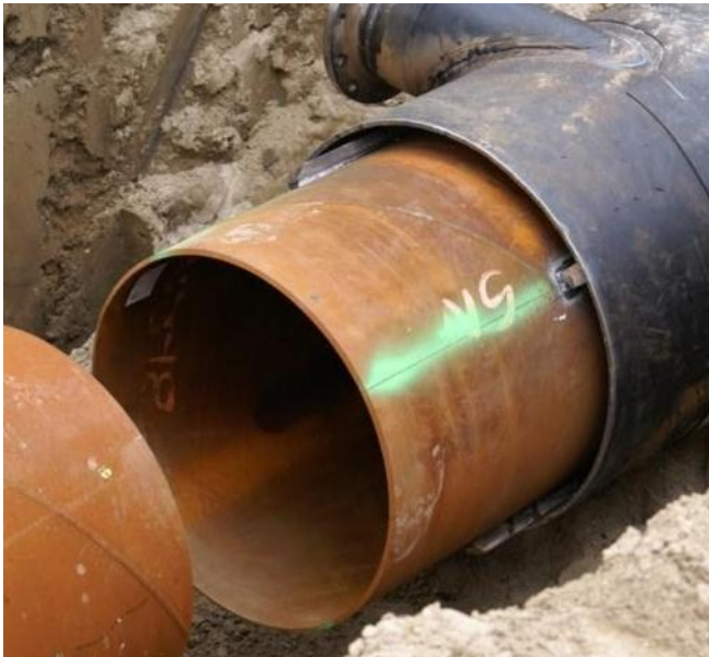
Doppelmantelrohrwärmetauscher
