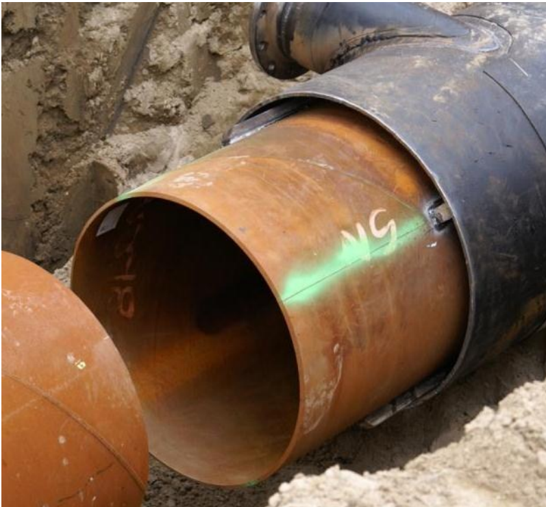
Doppelmantelrohrwärmetauscher
