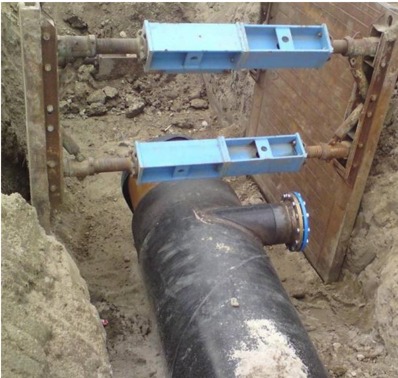
Anschluss Nahwärmetrasse
