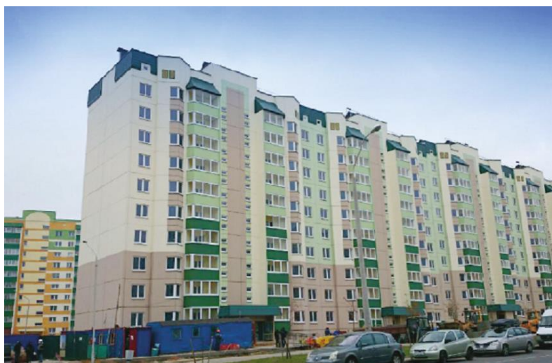
Типовой 10-ти этажный жилой дом в конструктивной системе неполный каркас на 180 квартир с четырьмя подъездами в г.Минске
