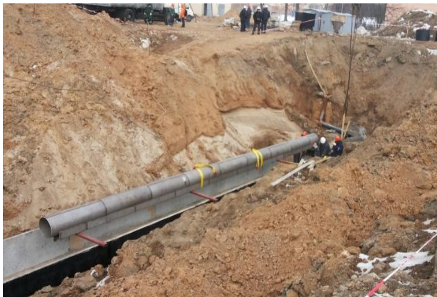
Рисунок 25 Монтаж теплообменной вставки в городской канализационный коллектор
