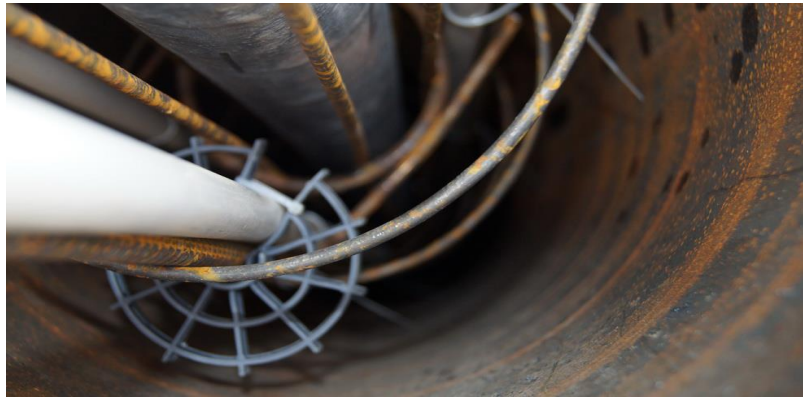
Рисунок 27 Устройство энергетической сваи на стадии монтажа
