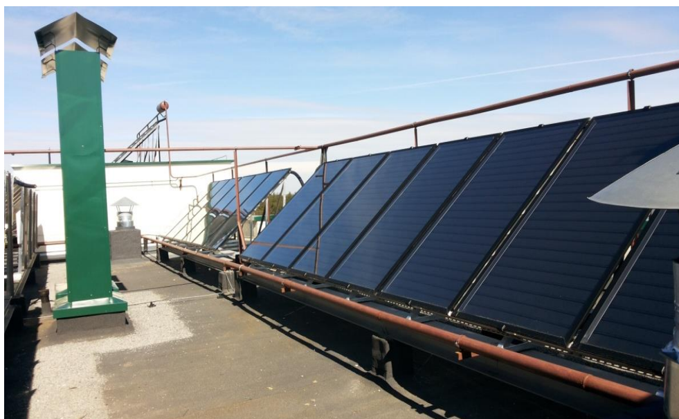
Рисунок 7 Фотография батареи солнечных коллекторов
