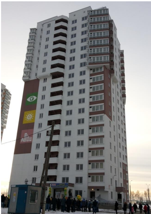
Рисунок 9 Энергоэффективное здание в г. Минске при сдаче в эксплуатацию
