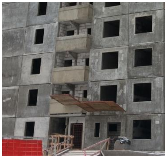
Рисунок 12 Фрагмент фасада здание в г. Минске на стадии строительства
