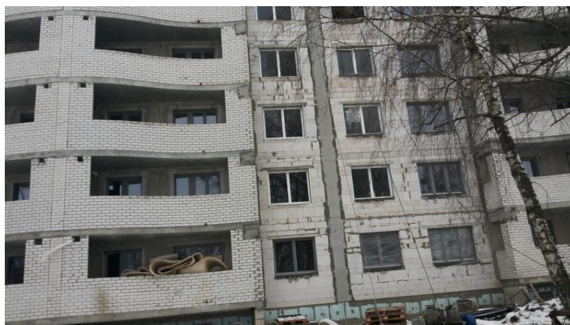
Рисунок 18 Здание в г. Гродно на стадии строительства
