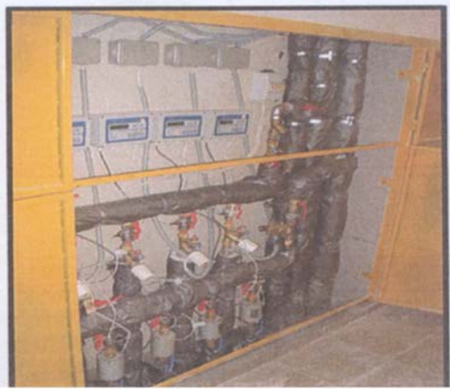
Узел управления с поквартирными системами управления
