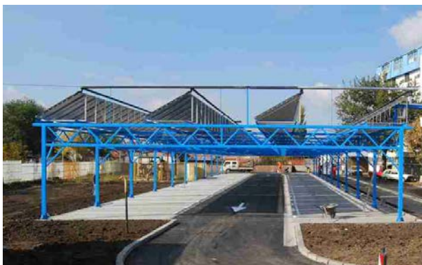
Рис.2. Второй вариант. Общий вид тепловых гелиоколлекторов, размещаемых на специальной металлоконструкции в непосредственной близости от жилого здания.
