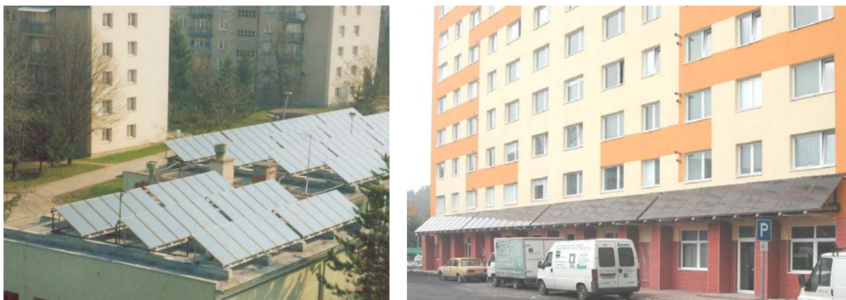
Рис.4. Варианты размещения тепловых гелиоколлекторов на крыше соседствующих с домом хозяйственных построек или на южной стене жилого дома.
