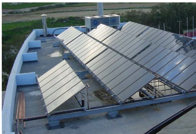
Рис.1. Первый вариант. Общий вид тепловых гелиоколлекторов, размещаемых с помощью несущей металлоконструкции на плоской кровле жилого здания.
