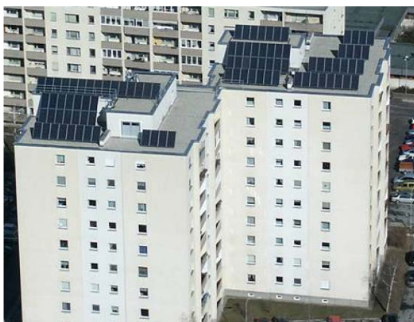
Рис.1. Первый вариант. Общий вид тепловых гелиоколлекторов, размещаемых с помощью несущей металлоконструкции на плоской кровле жилого здания.
