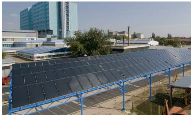
Рис.2. Второй вариант. Общий вид тепловых гелиоколлекторов, размещаемых на специальной металлоконструкции в непосредственной близости от жилого здания.
