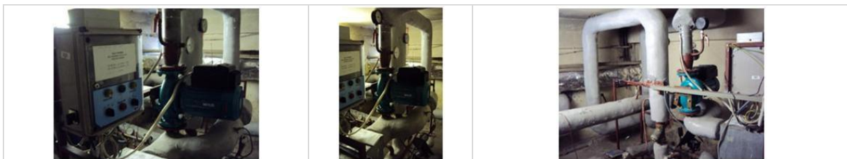
Пример: График выставления температур: 20°C - с 6.00 до 13.00; 14°C - с 13.00 до 6.00
